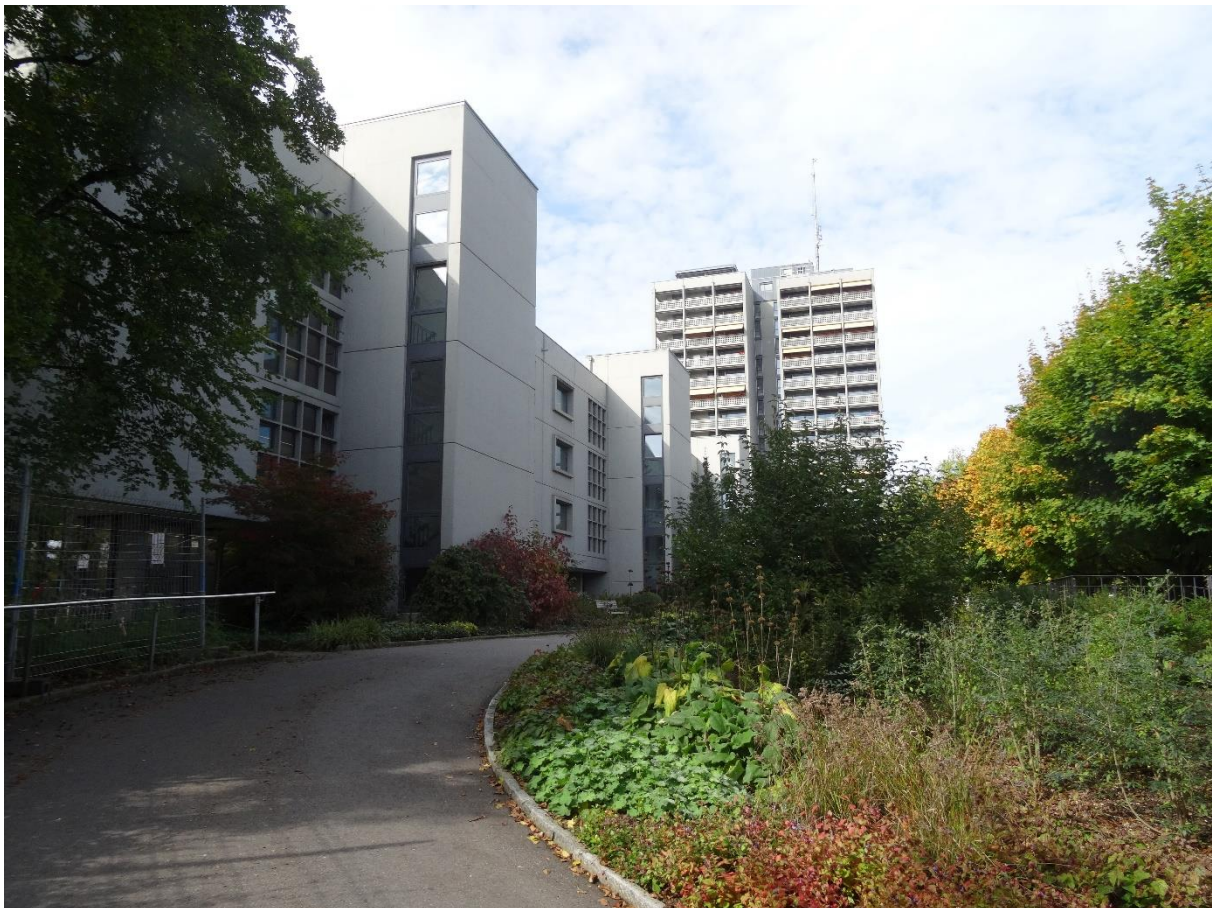
Abbildung 8: Der Burgerspittel im Viererfeld mit «Scheibenhaus» (links) und «Hochhaus» (hinten) (Foto M. Gfeller)
