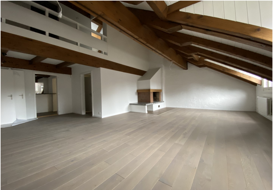
Umbau Zunfthaus: Sanierte Wohnung im 4. Stock links
