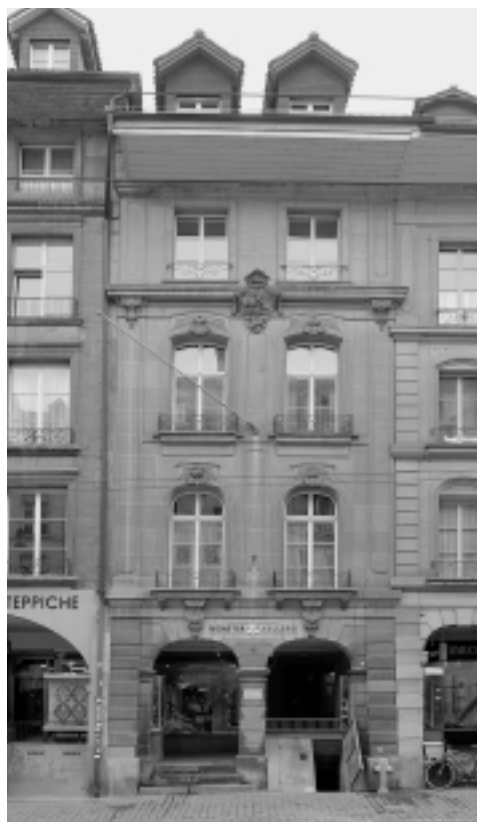
Fassade Kramgasse 45, gebaut 1769/1770
